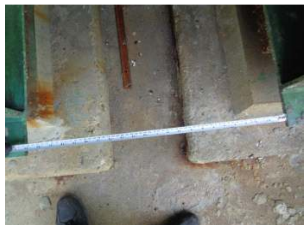
거더 이동량 측정
