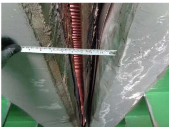
바닥판하면 이동량 측정
